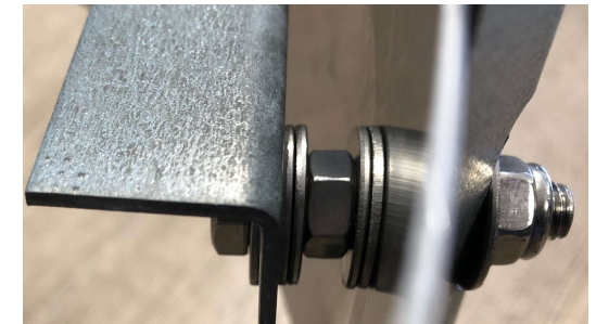
Détails fixation patte/ceinture/équerre L'assemblage équerre, ceinture et pied est réalisé dans ce sens par : 1 vis TH M8x45, 1 rondelle D8/22, équerre, 2 rondelles D8/22, 1 écrou H M8, 2 rondelles D8/22, ceinture, 1 rondelle D8/22, 1 écrou H M8, pied, 1 rondelle D8/22 et un écrou H M8 Nylstop
